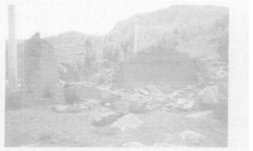
图 11 被乃托沟泥石流冲毁的房屋
