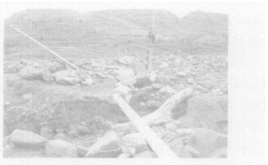
图 12 泥石流冲毁通讯和电力设施
